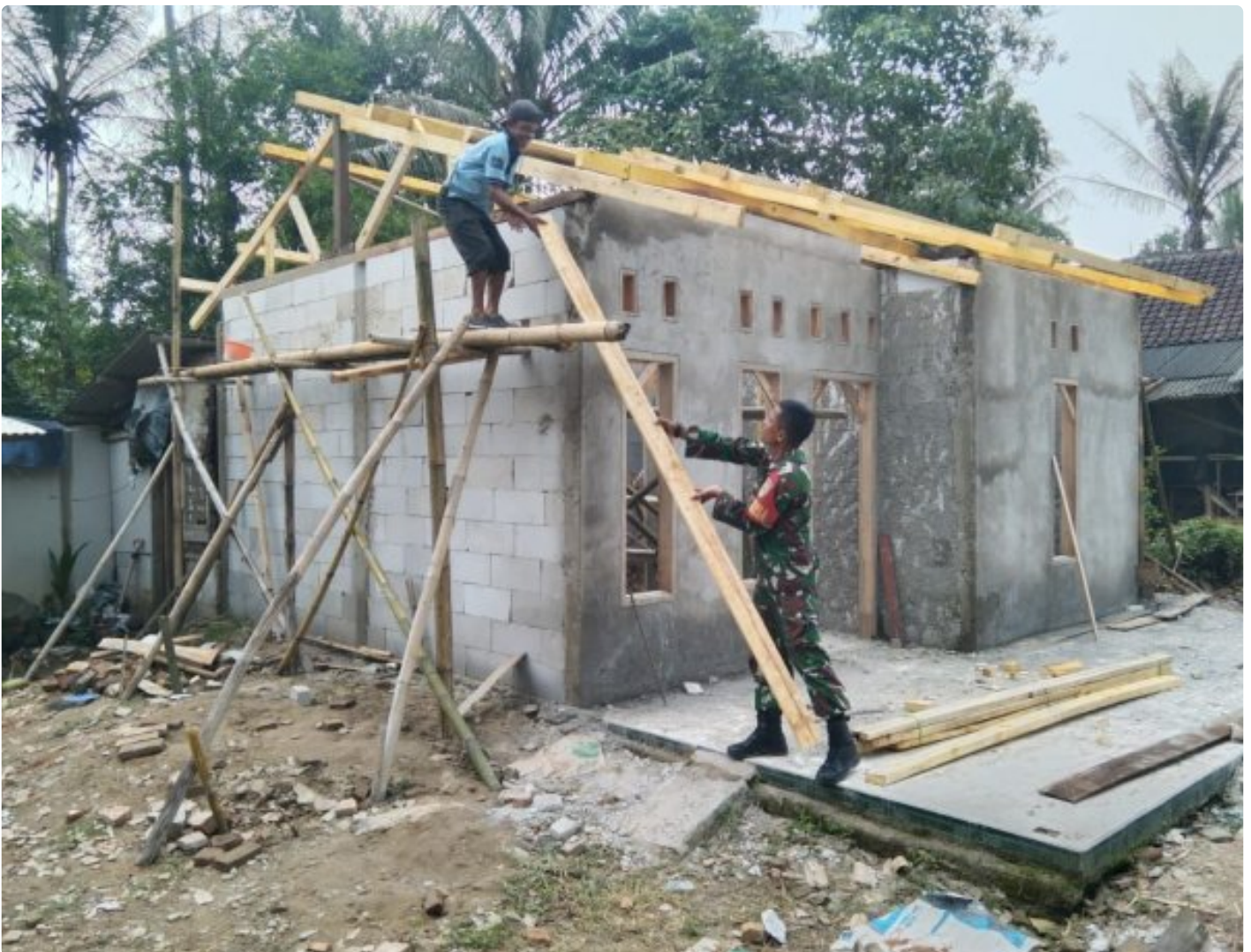
Serda Naya membantu pemasangan atap RTLH
